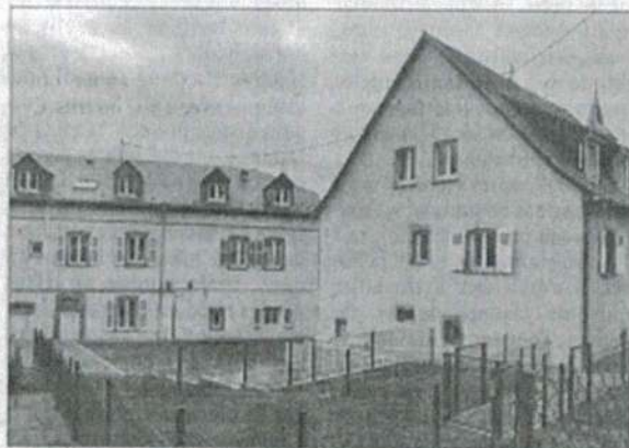
Vue arrière de la résidence Saint-Jacques à Walbach, avec ses places de stationnement et ses jardins privés. La maison individuelle (à droite) abrite deux logements T4, et l'ancien presbytère six logements (deux T2 et quatre T3). Photo DNA/Christophe ANSEL
